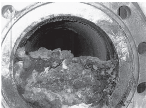
Obrázek 13: Nánosy korozivních produktů ( \text{FeCl}_3 ) v potrubí na dopravu plynného chlóru zjištěného při podobné události ve francouzském Champagner v roce 2005 (zdroj: ARIA/IMPEL).
