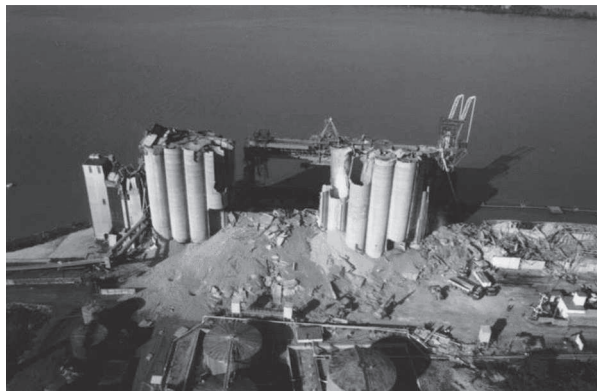
Obrázek 15: Pohled na silo po explozi (zdroj: ARIA/IMPEL).
